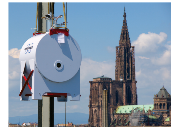
Pesant environ deux tonnes, c'est par le toit de l'IBMP que Solarix FTMS a été livré. © Jean-Luc Evrard
